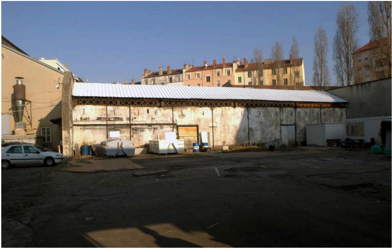
Hangar jouxtant l'atelier, depuis l'est
