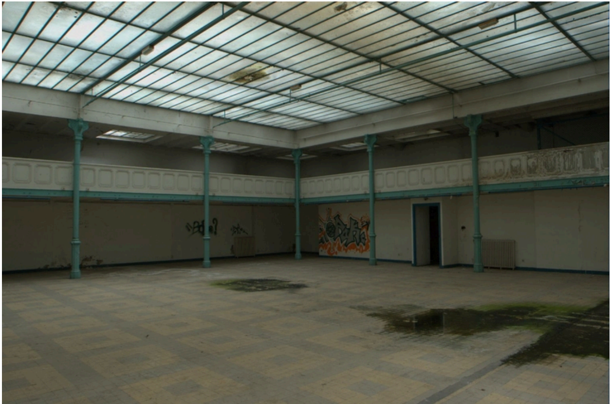
Vue nord-est de la halle
