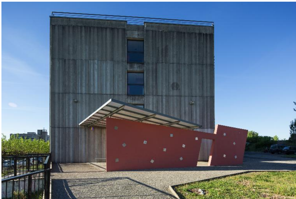
Bâtiment nord : pignon nord.
