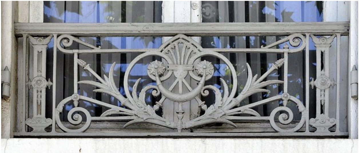
Garde-corps du rez-de-chaussée
