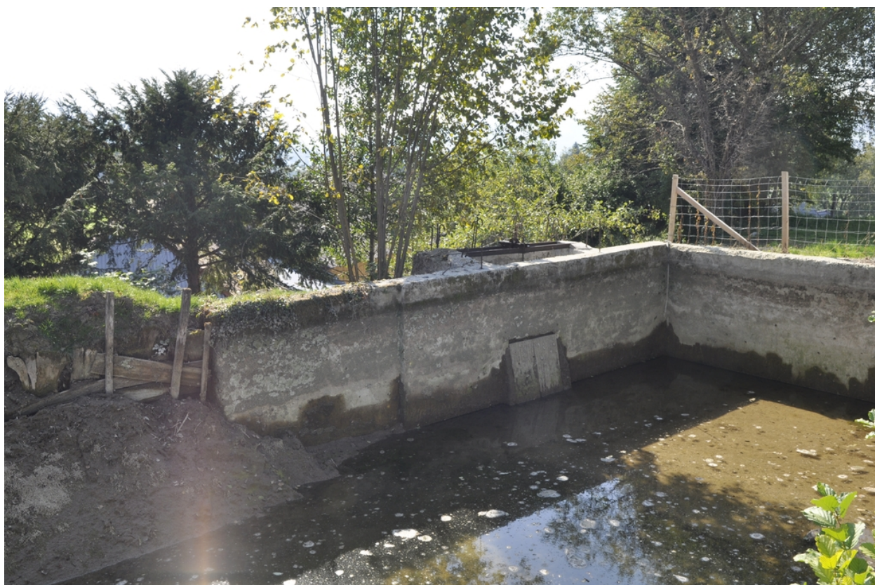
Vue de la retenue côté aval.
