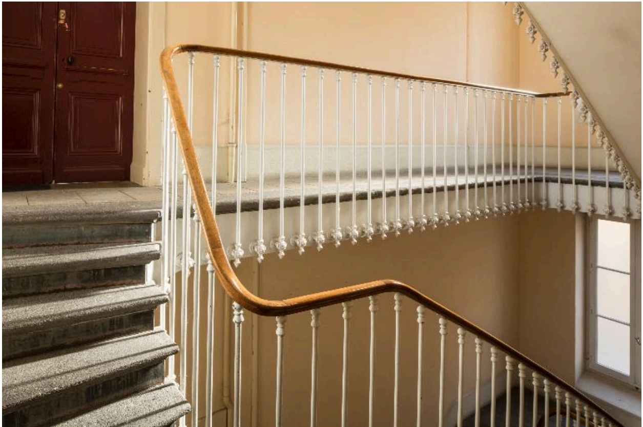
Bâtiment E. Logements de fonction. Escalier
