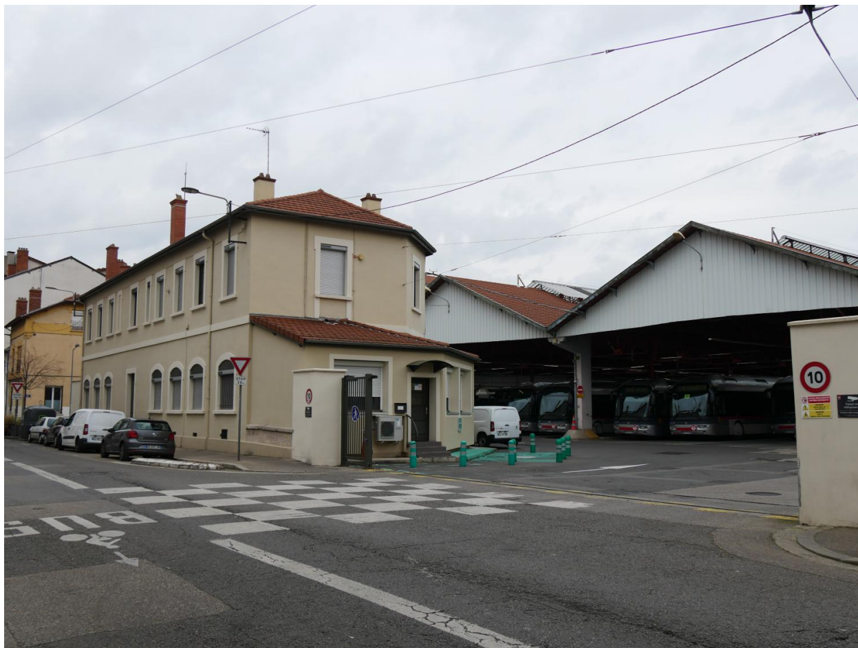
Entrée principale rue d'Alsace
