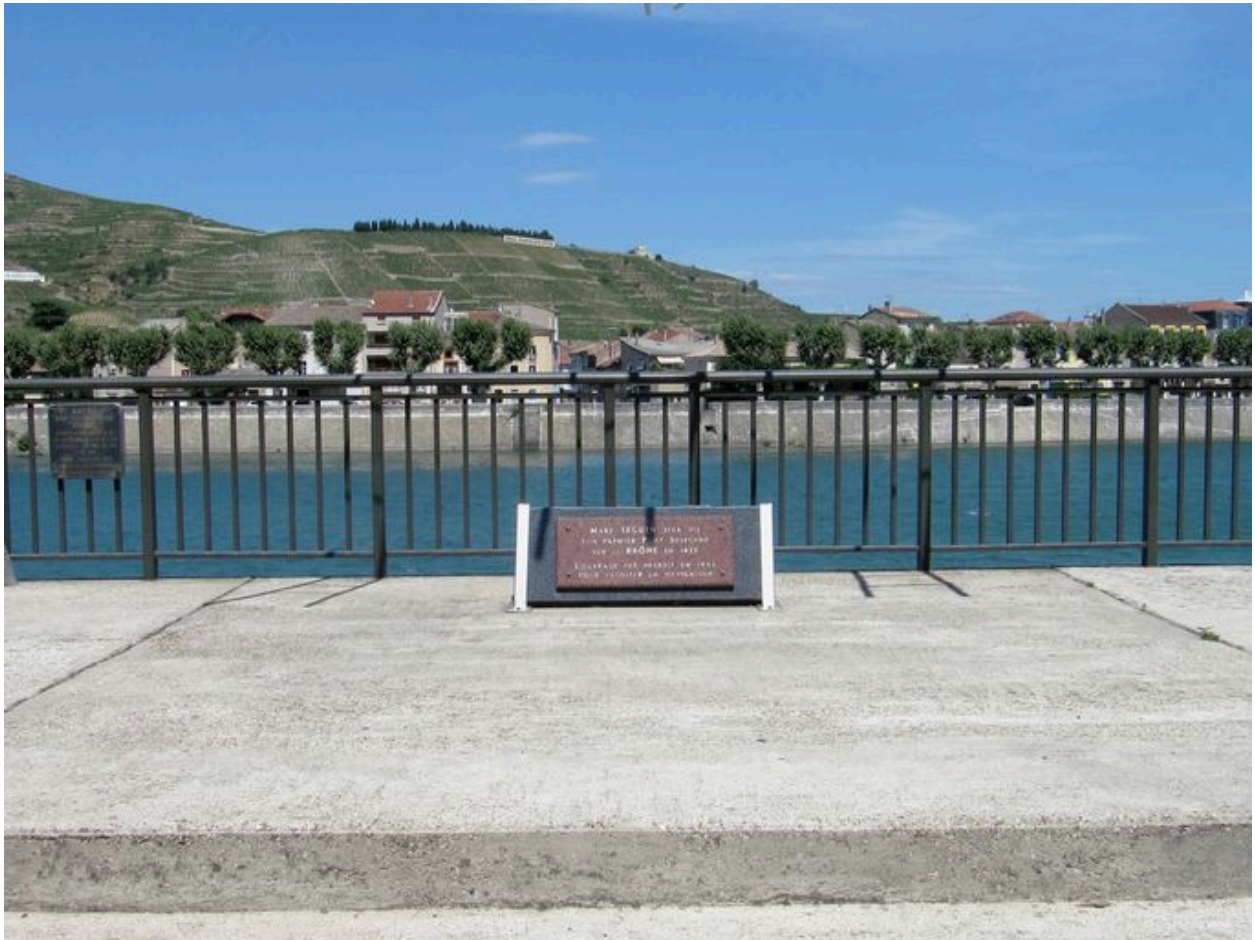
Débouché du pont, vue générale (depuis la plate-forme de la culée de rive droite) ; plaque commémorative
