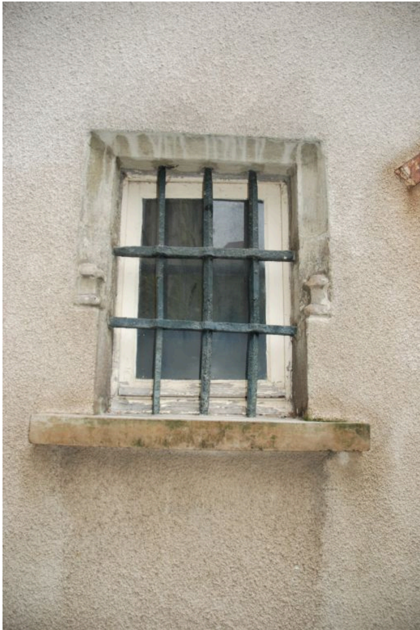
Elévation latérale du pavillon de droite, détail d'une baie moulurée sur bases prismatiques, 16e siècle.
