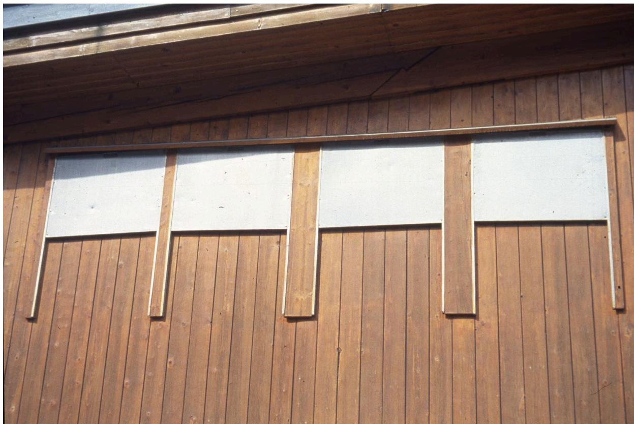
Détail des baies de la façade nord
