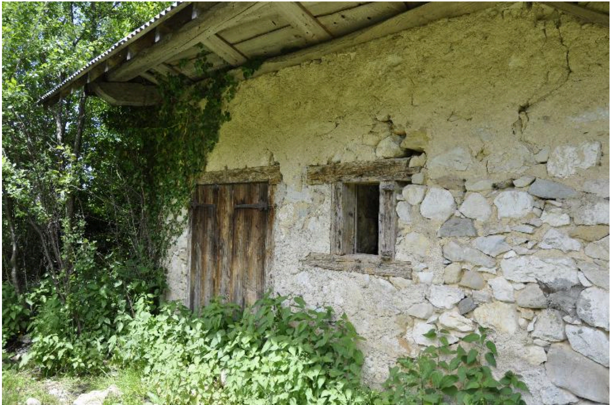
Vue de la façade de l'étable.
