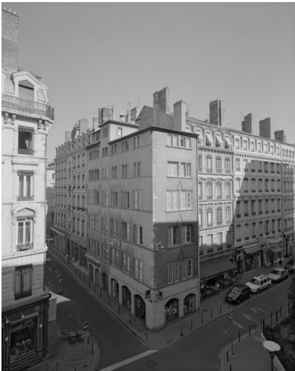
Vue générale des façades à mi-hauteur
