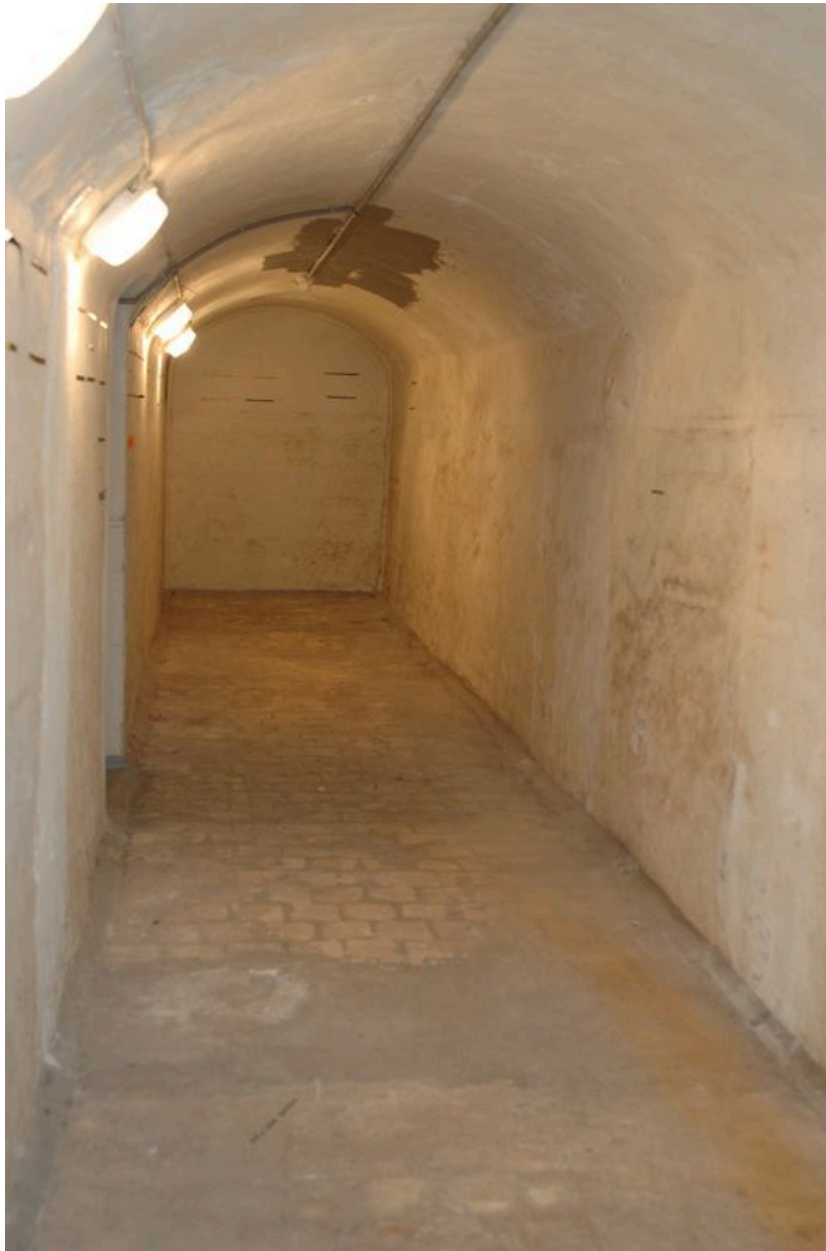
Vue d'un des sous-sols du bâtiment des malades.
