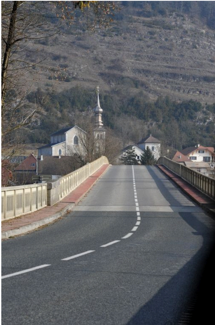
Vue générale, de dessus, chaussée (depuis la rive droite)
