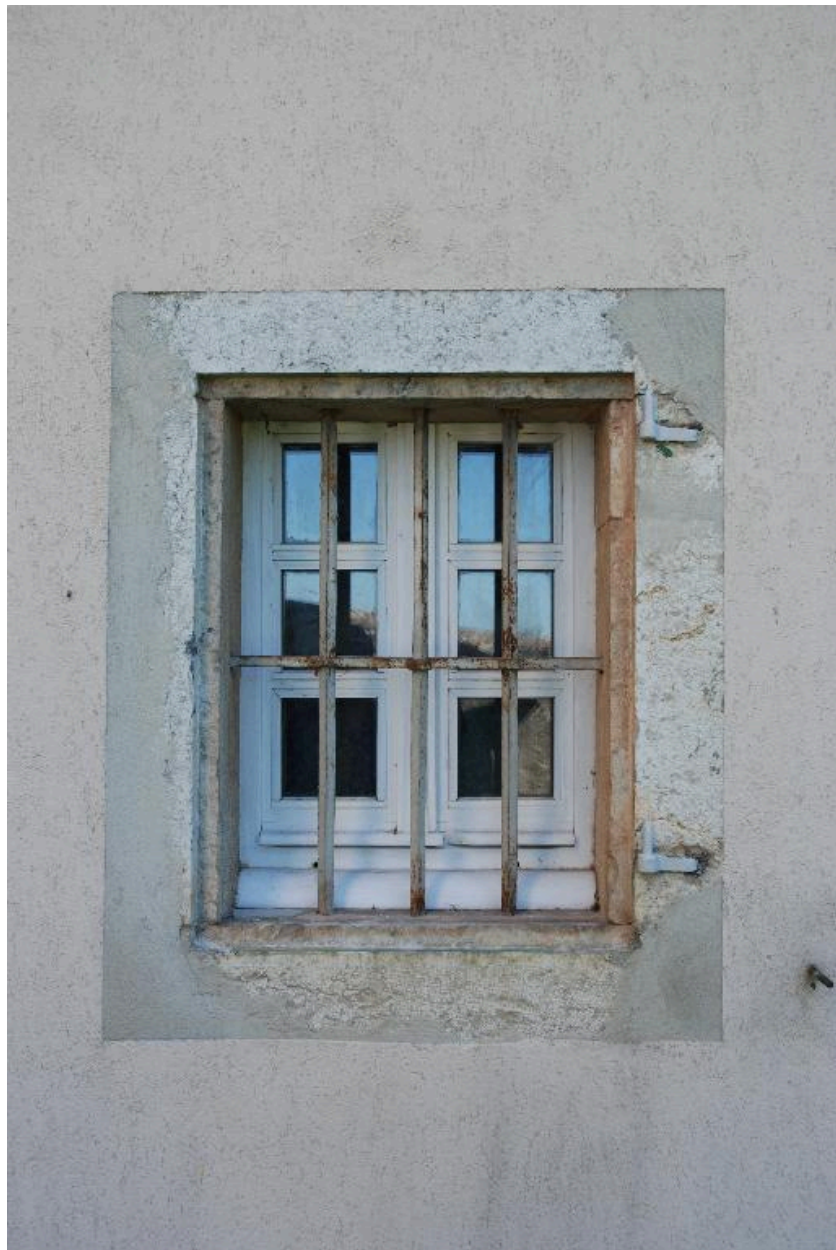
Elévation ouest du corps de bâtiment central : détail de la fenêtre.
