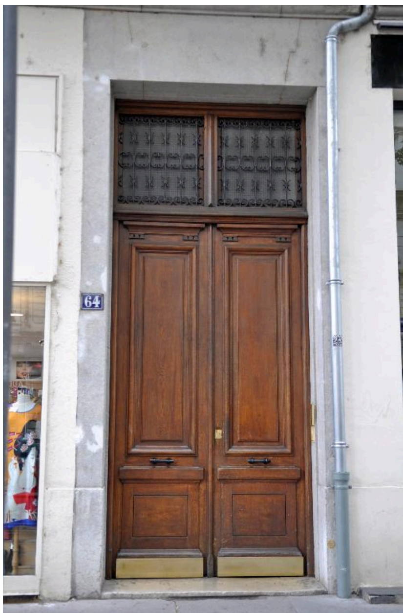
Elévation sur l'avenue Jean-Jaurès, porte bâtarde
