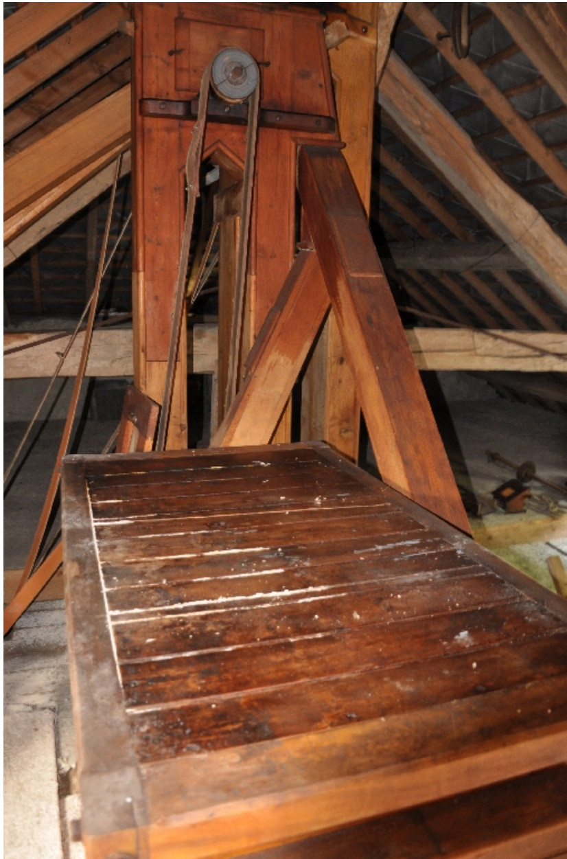
Etage de comble : vue de la trieuse de son et de l'ascenseur.
