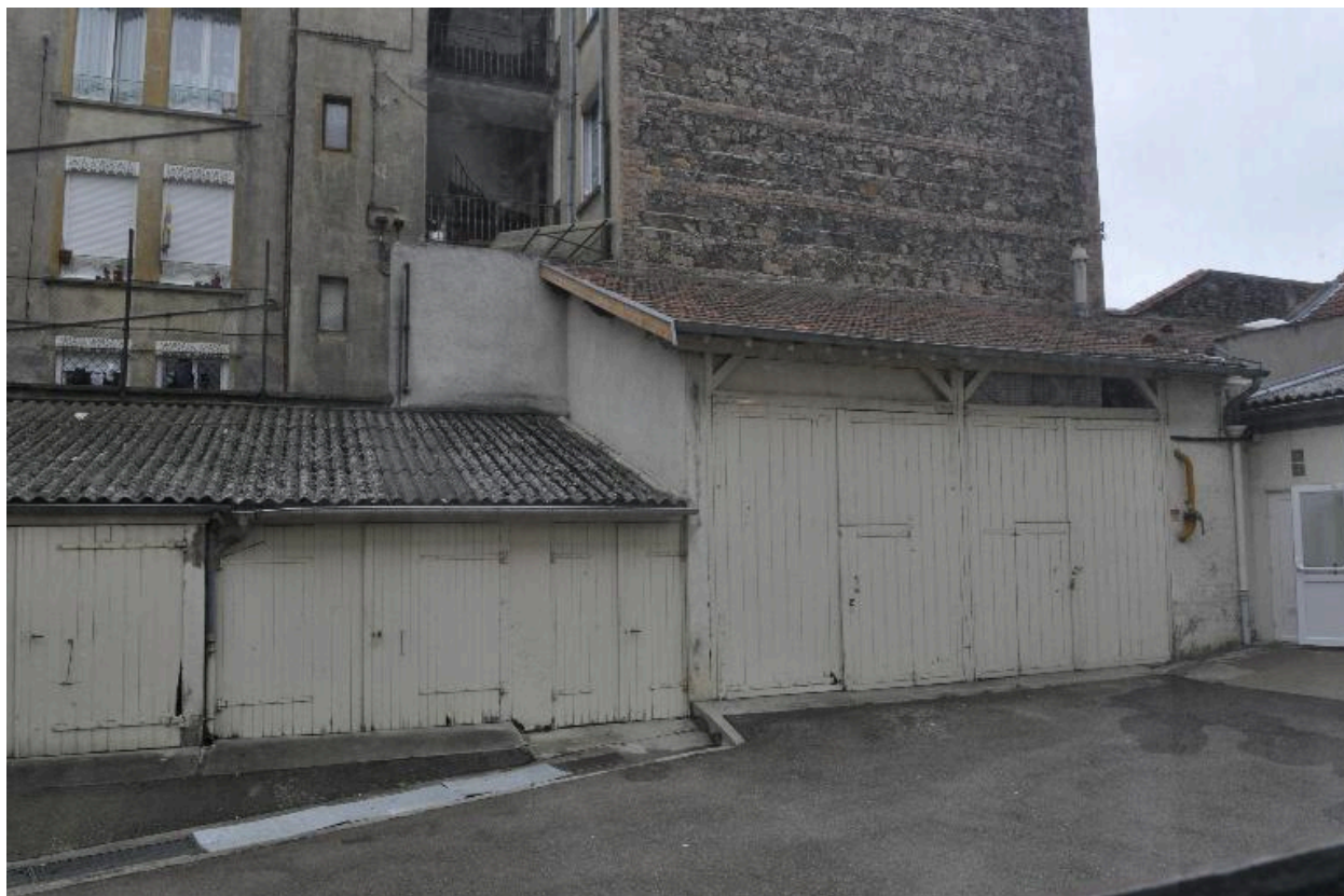
Dépendances au sud du bâtiment F
