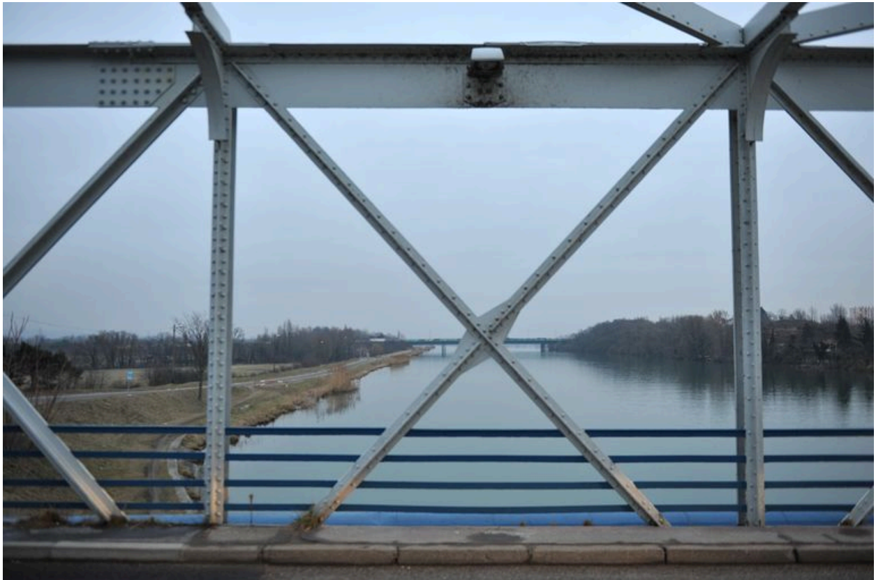
Structure métallique du tablier, face amont, vue partielle (depuis la chaussée)
