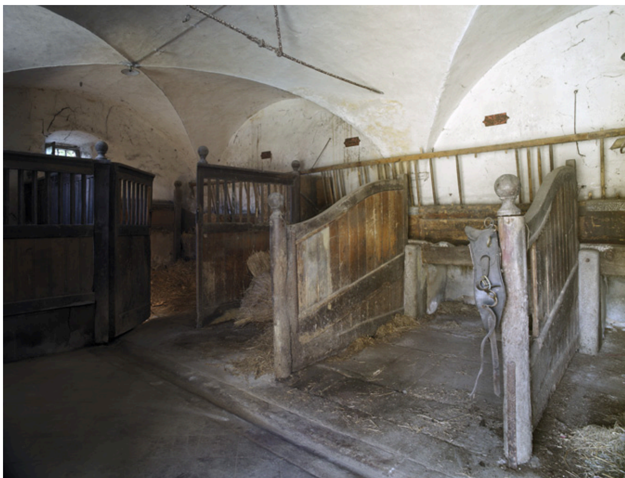
Vue intérieure de l'écurie (bâtiment ouest).
