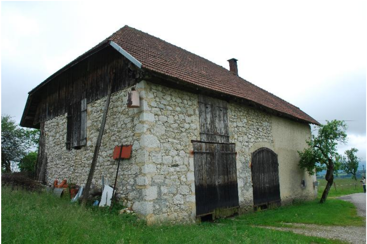
Vue d'ensemble de trois quart arrière gauche.
