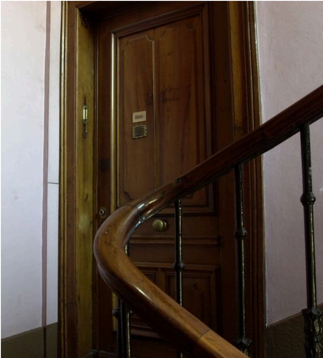
Vue d'une porte pallière
