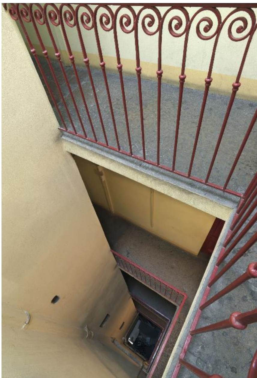
Vue du système de distribution et des paliers d'étages après le couloir d'accès du n°29 impasse Gigodot
