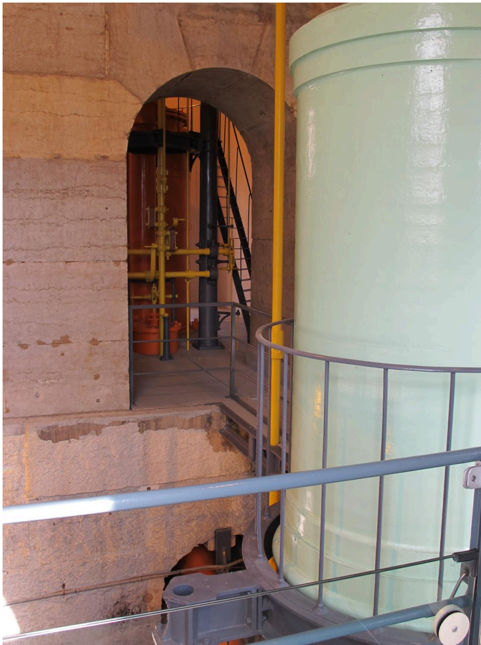
Détail bâtiment pompe
