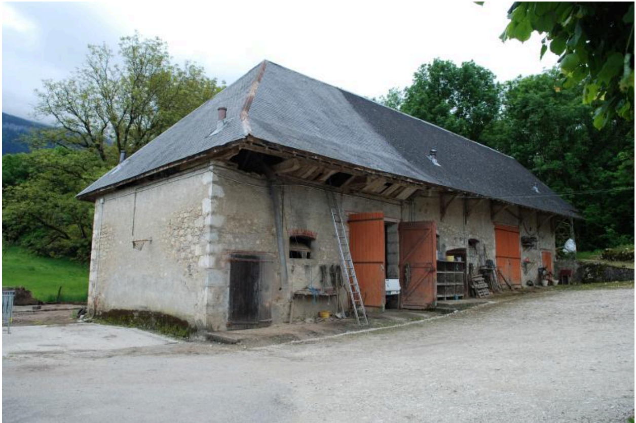
Vue d'ensemble de la grange-étable ouest de trois-quarts avant gauche.
