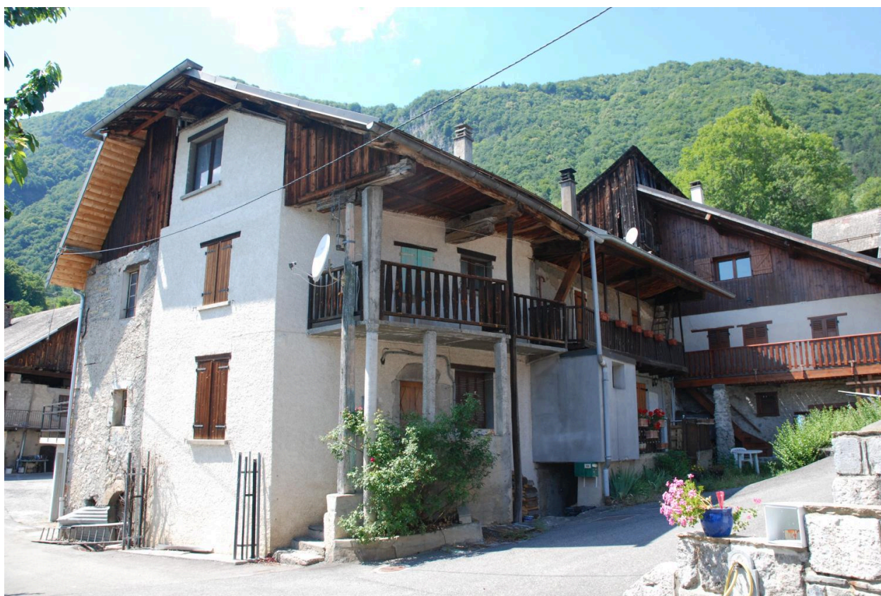
Maisons de vigneron (les Allues-dessous, 2018 YE 129, 134, 135).
