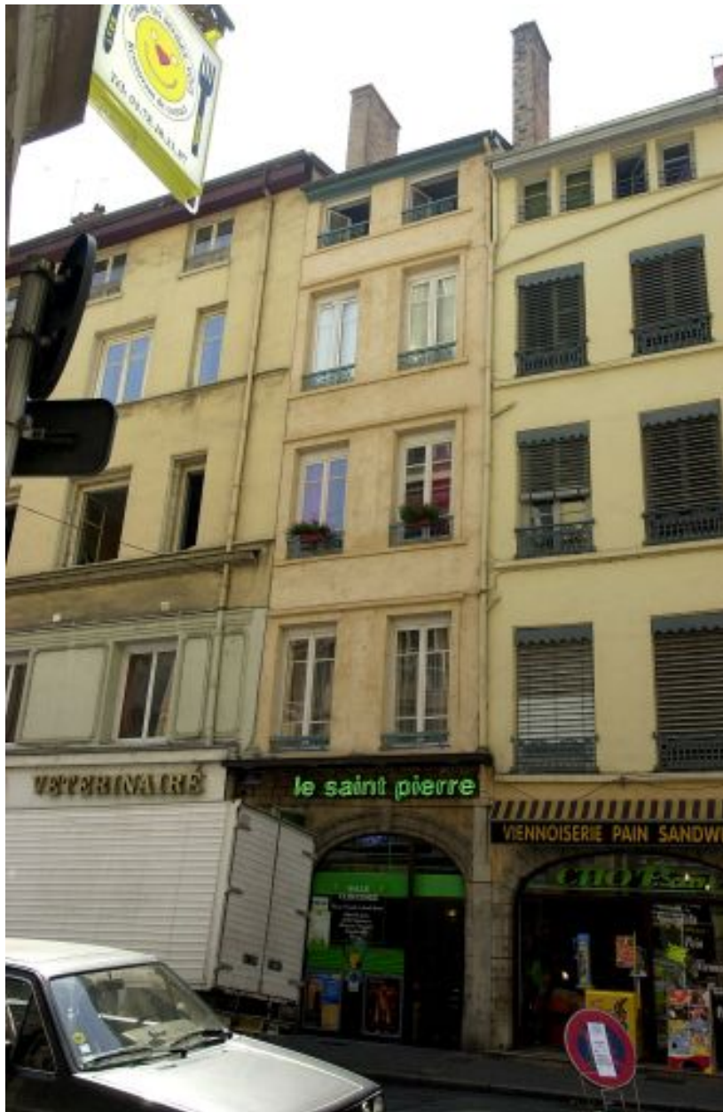
Façade principale sur la rue de la Platière
