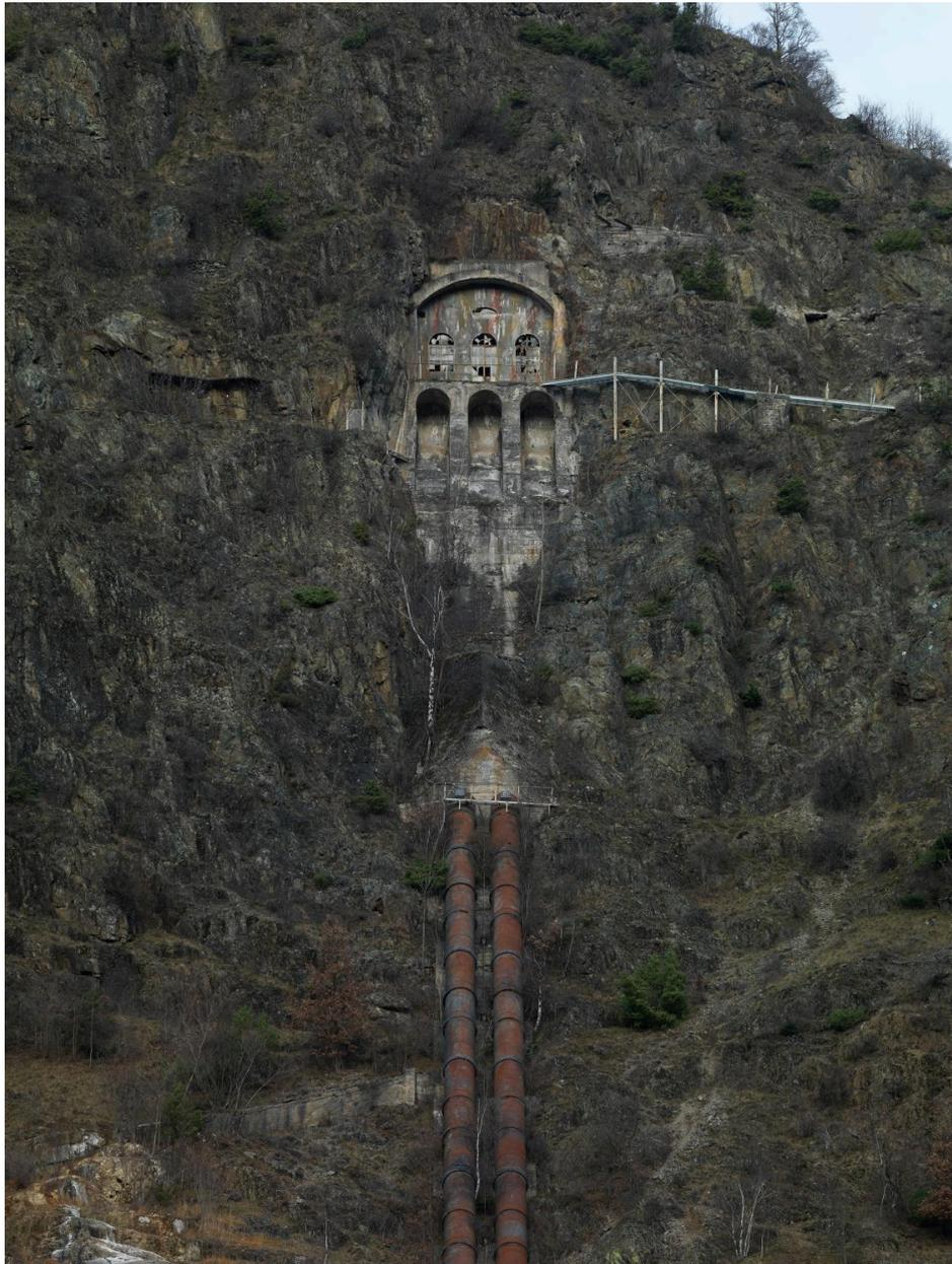
Détail de la chambre de mise en charge du Chambon.
