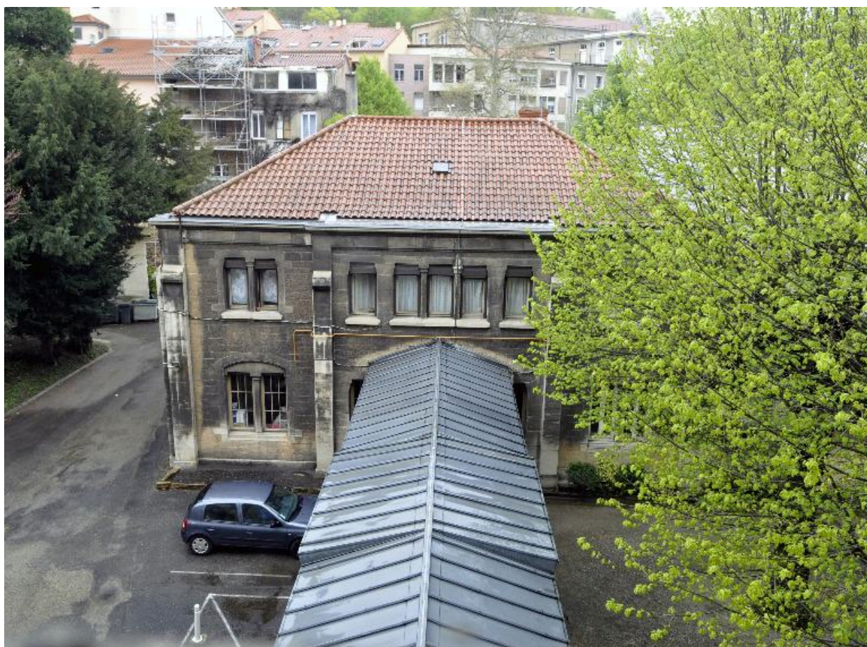
La porterie depuis le sud-est
