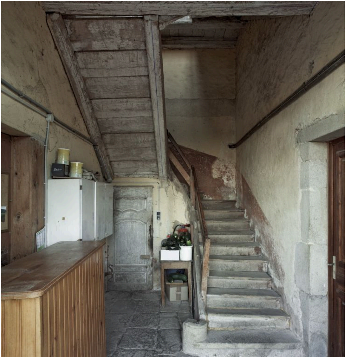
Aile nord de la maison forte, rez-de-chaussée, vue d'ensemble de la cage d'escalier du 18e siècle.
