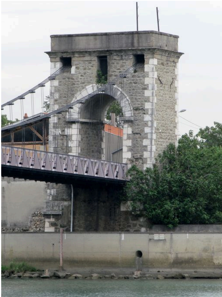
Pile gauche, face aval, vue générale (depuis la rive droite)
