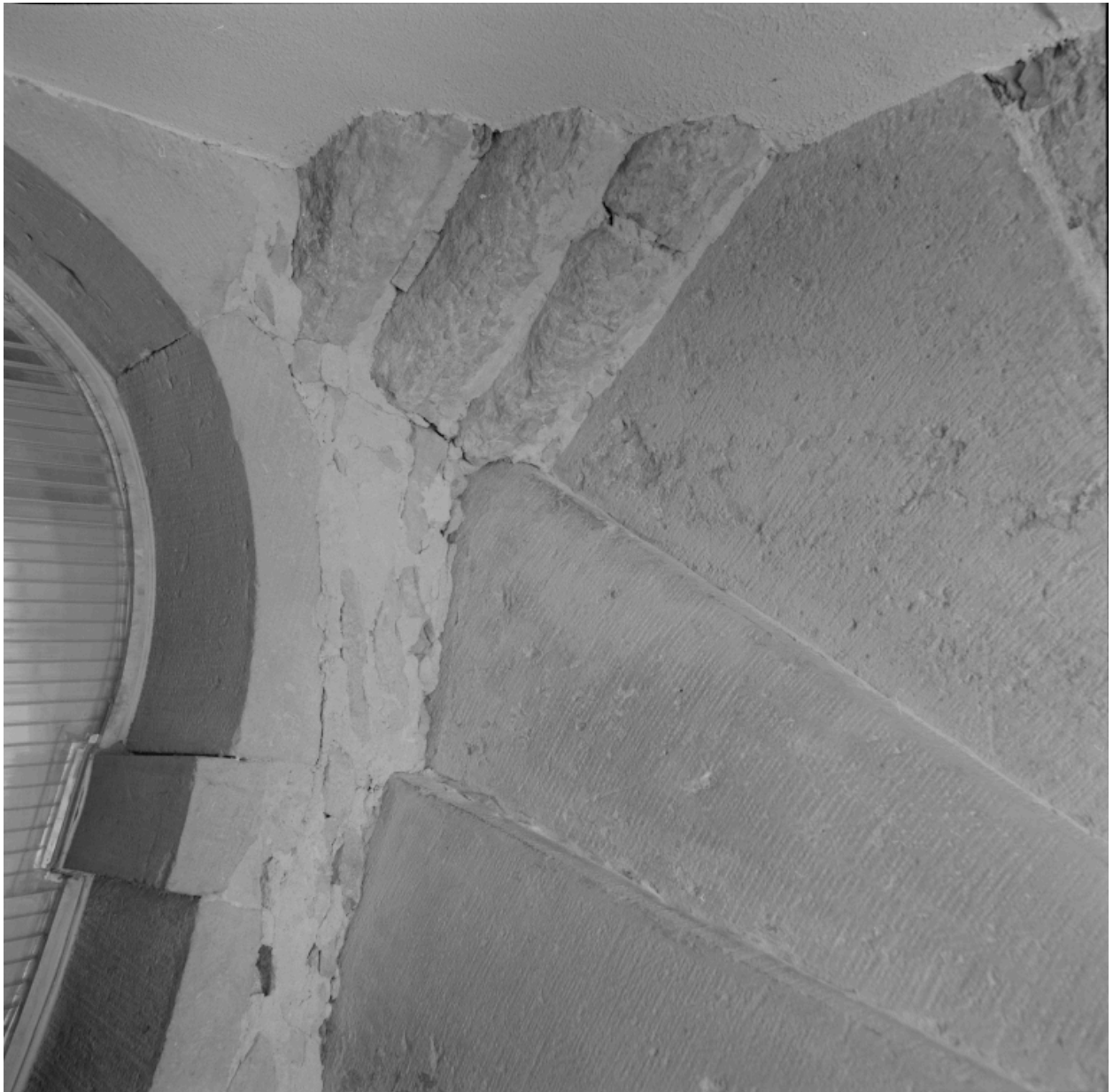
Escalier : détail de support.
