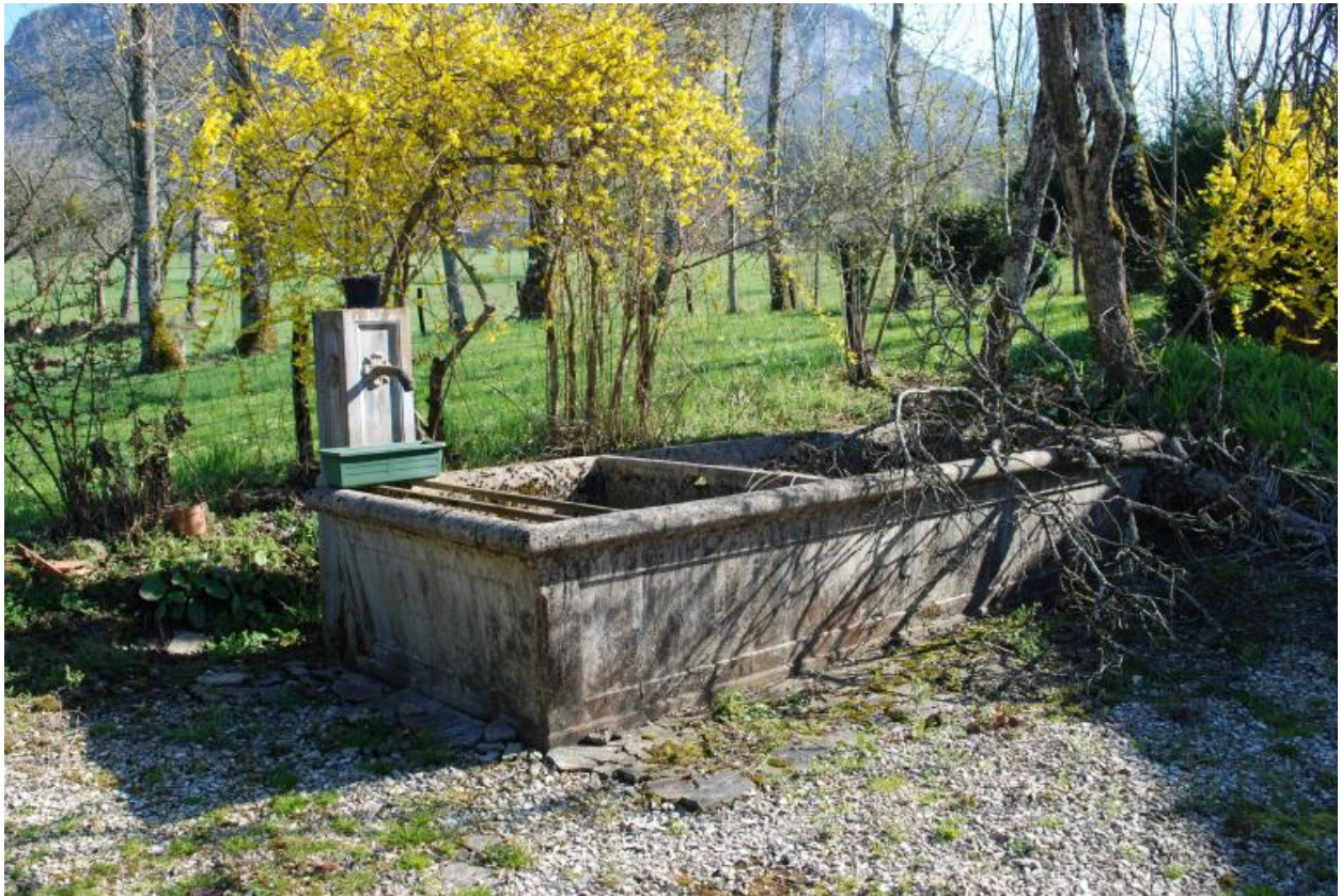
Vue d'ensemble du bassin-lavoir.
