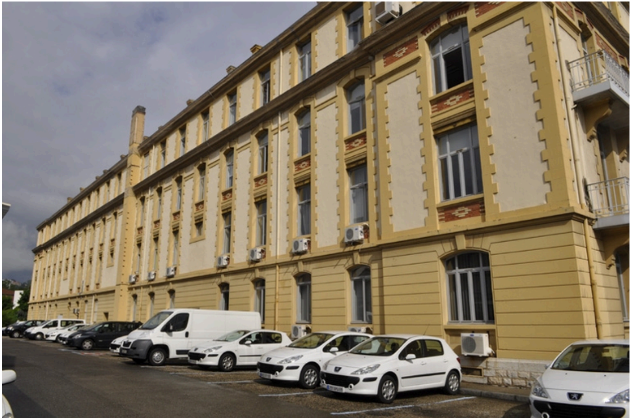
Bâtiment de 1916 : vue de la façade sud.
