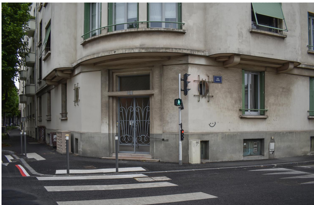
Porte d'entrée de la travée d'angle
