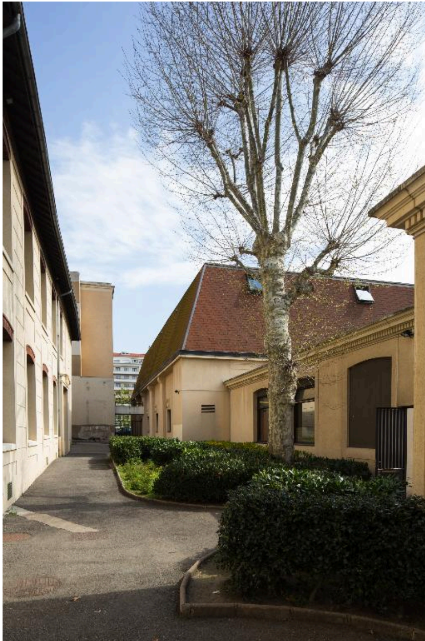
Chemin d'accès aux bâtiments A, E et F
