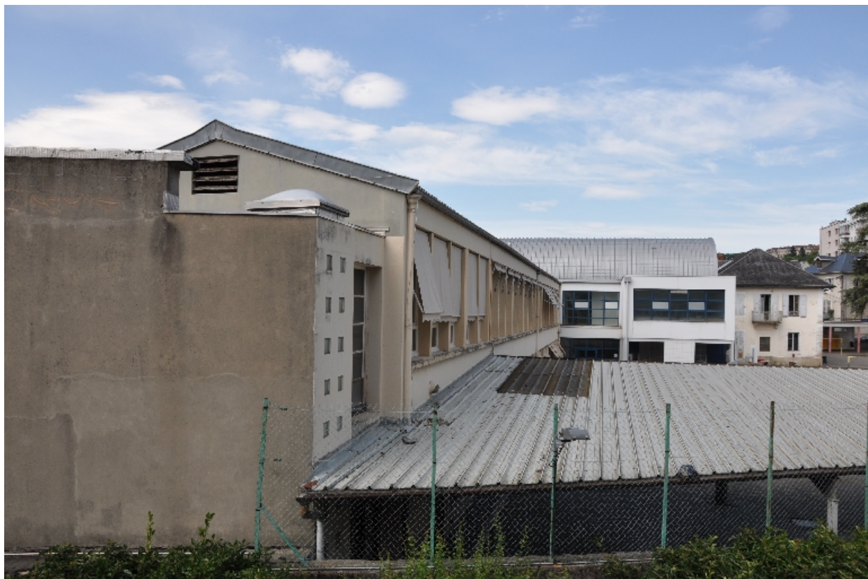
Vue depuis l'arrière de la cour
