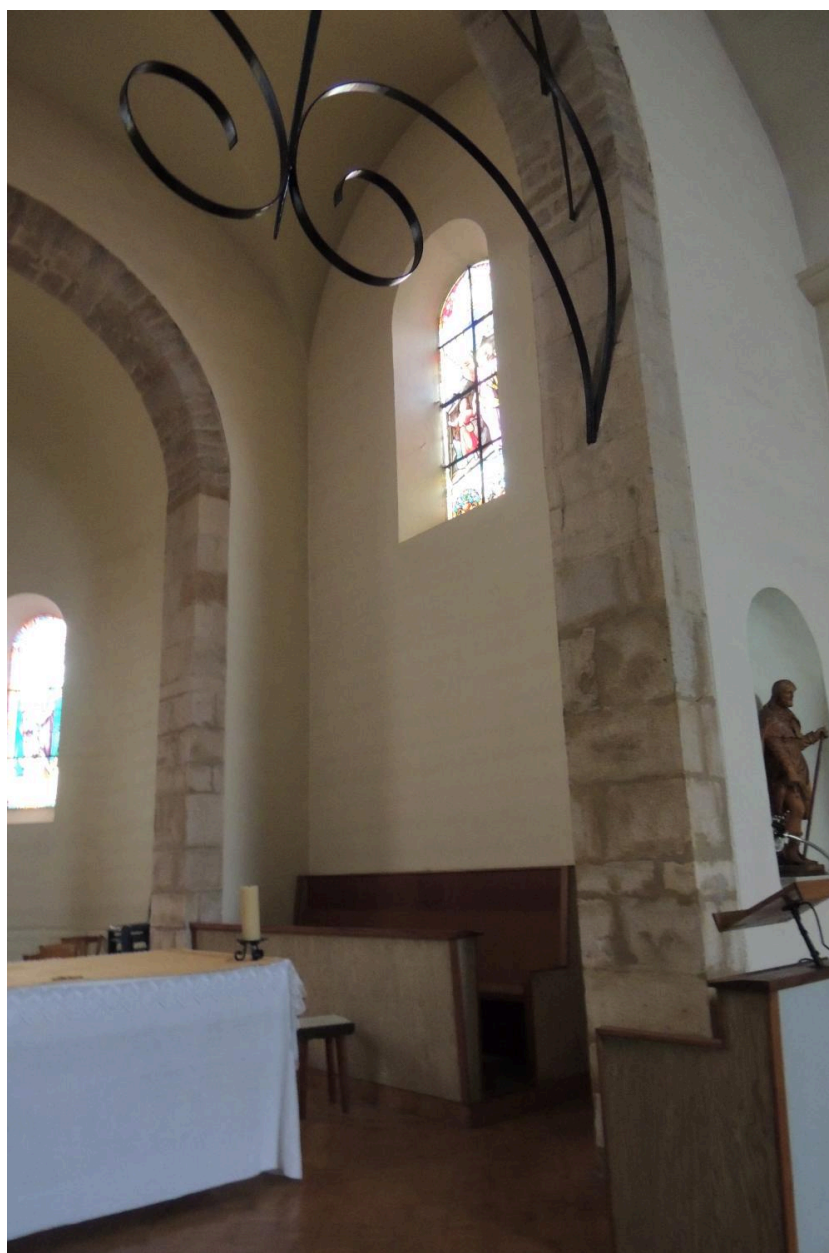
Travée de chœur, élévation sud.
