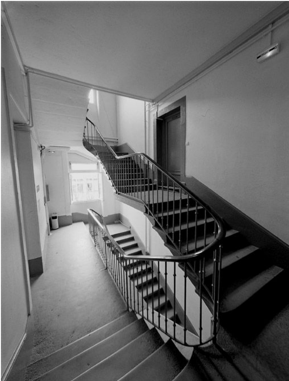
Aile sud du cloître, grand escalier vu depuis le premier étage
