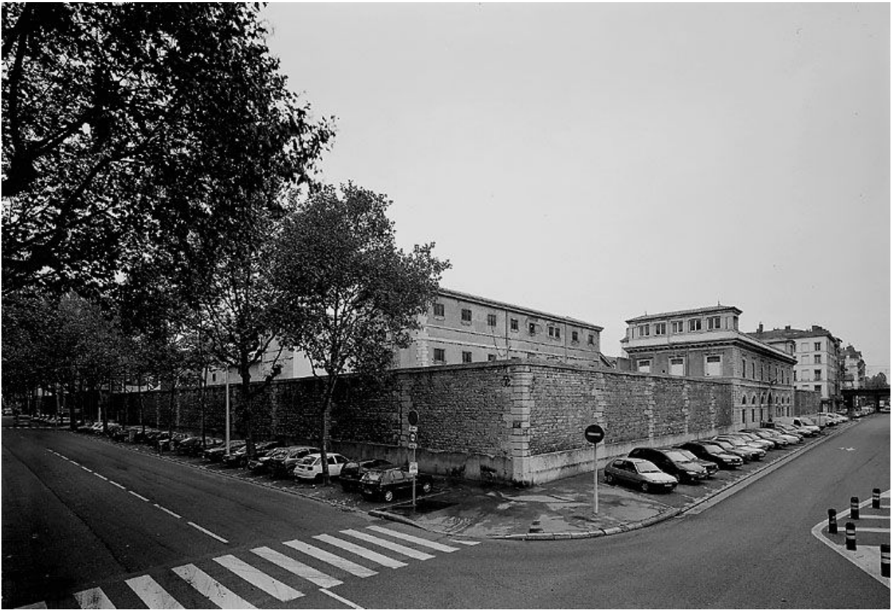
Vue générale depuis l'angle du quai Perrache et du cours Suchet
