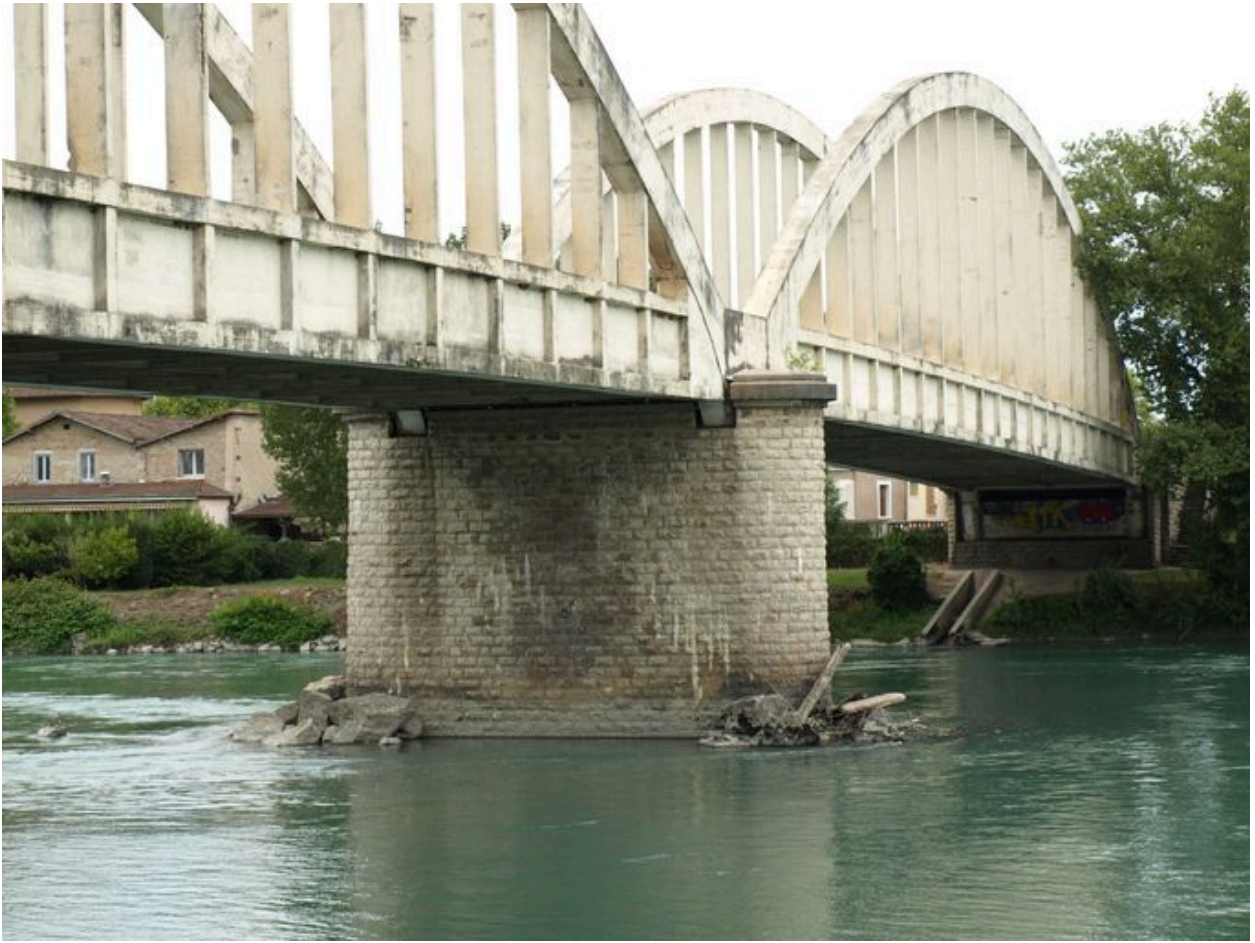
Vue partielle, travée et culée droite, face amont (depuis la rive gauche)
