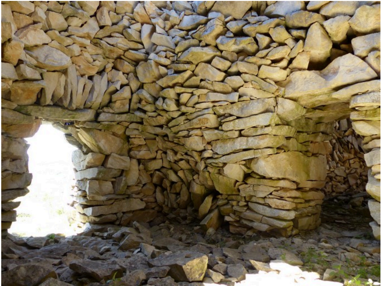
Travée centrale. Vue de volume prise du nord-est.
