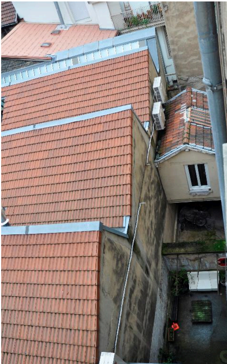
Vue de la cour et de la loge en encorbellement
