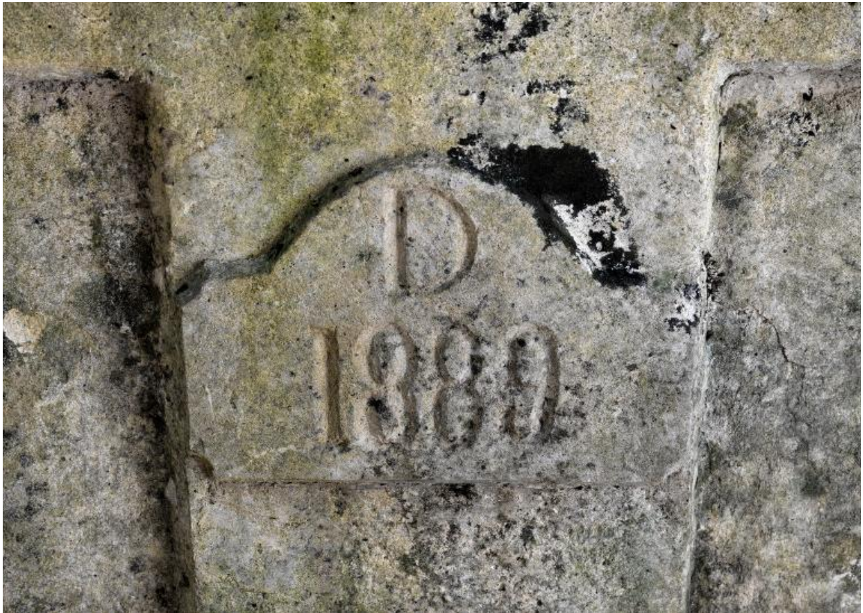
Bassin en béton, détail de la date moulée sur la face avant.
