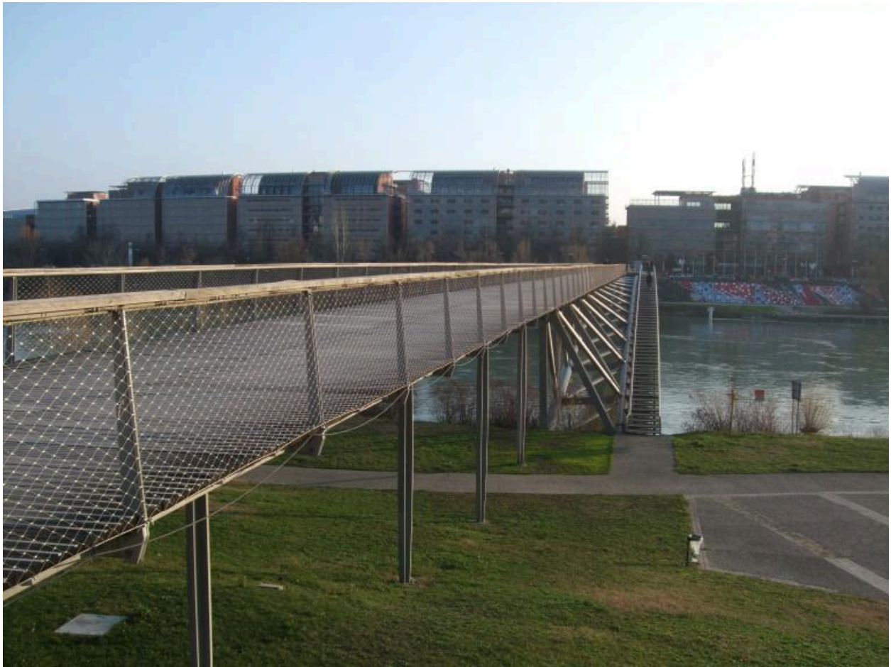
Vue sud-ouest de la passerelle
