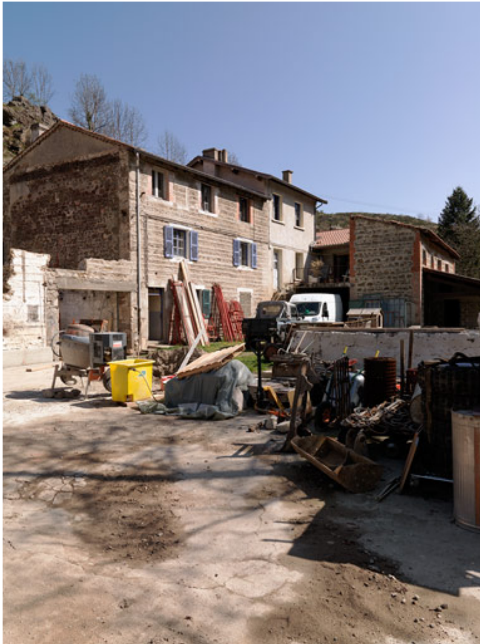
Vue d'ensemble du bâtiment nord, depuis le sud-ouest.
