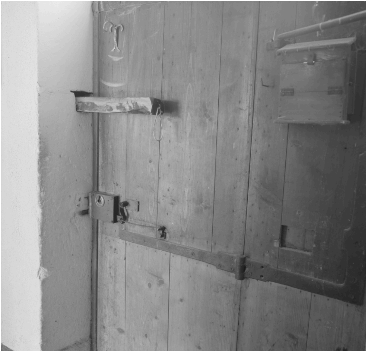
Rue des Fontaines, maison (AX 199), porte d'entrée du logis : système de verrou intérieur en bois.
