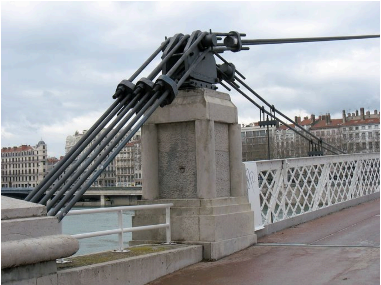
Vue d'un massif d'ancrage
