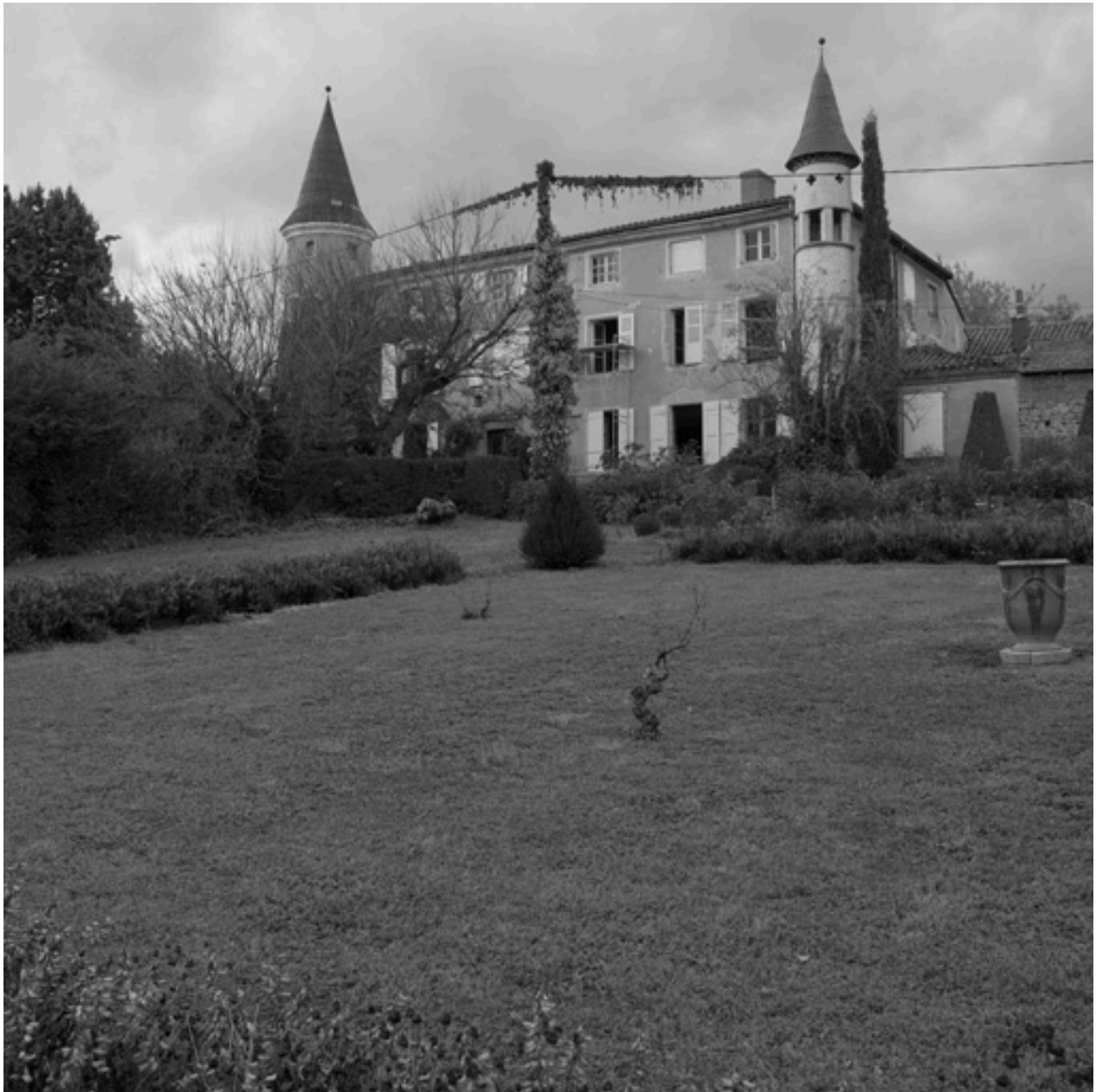
Vue d'ensemble de la façade sud.
