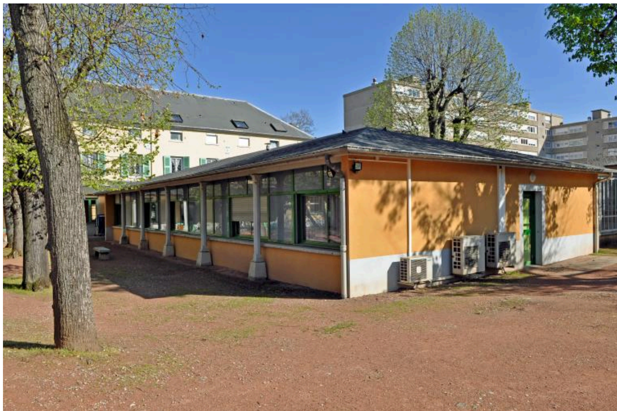
Cour nord-ouest, salle construite en réemployant les piliers des anciens portiques
